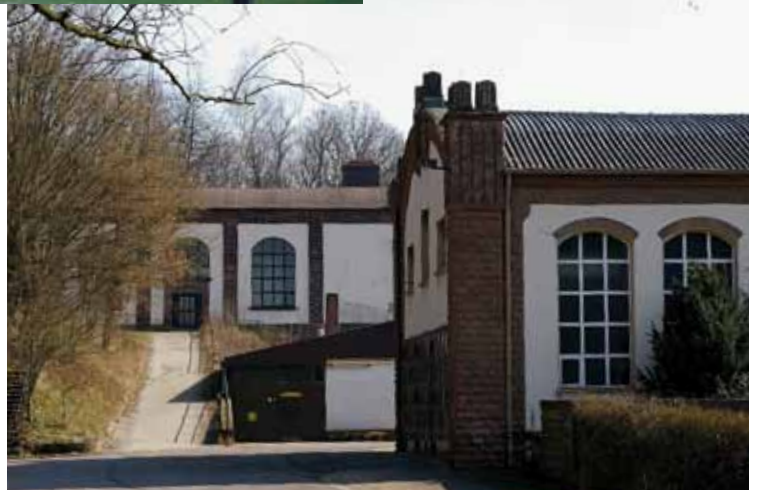
Friedrichsthal: Ostschachanlage, vormals Haupttrittsstelle – Zechenhaus und Fördermaschinenhaus (links, 1907).
