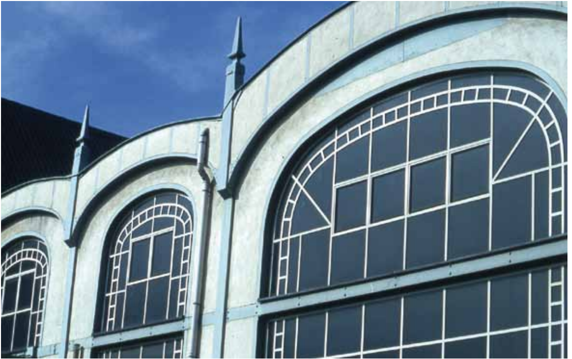
Neunkirchen-Heinitz: Kokereigaschinenzentrale Heinitz – Detail der Korbboogen und Sprossenfenster (1904/20).
