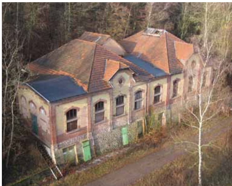
Schiffweiler-Heiligenwald: Elektrische Zentrale (Schalthaus) der Grube Itzenplitz (1907/15).
