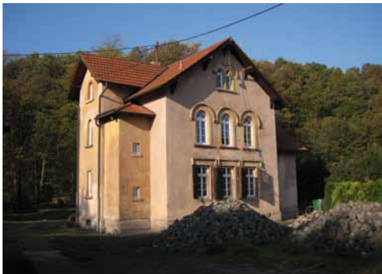
Schiffweiler-Heiligenwald: Stationsgebäude des Itzenplitzer Grubenbahnhofs (1905).
