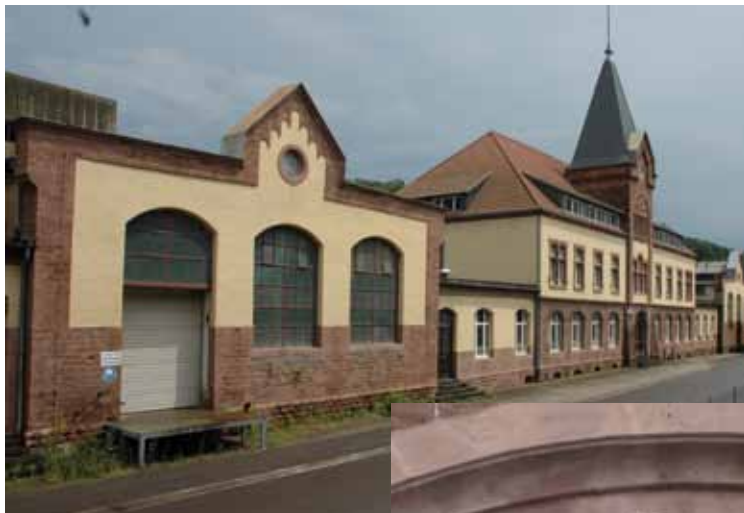
Saarbrücken-Velsen: Zechenhaus der Grube Velsen – Gesamtansicht (1908/12).
