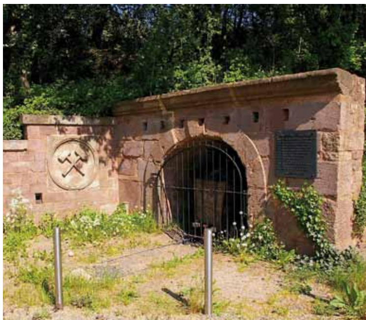
Heusweiler-Dilsburg: Mundloch des Dilsburg-Stollens (1844/45).
