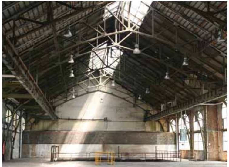
Neunkirchen-Heinitz: Kokereigasmaschinenzentrale Heinitz mit offener Stahlfachwerk-Trägerkonstruktion (1904).
