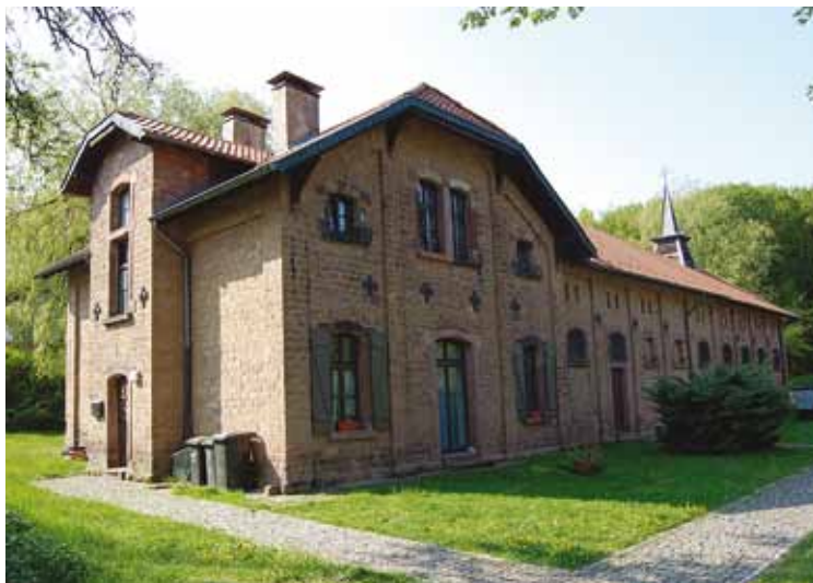
Sulzbach-Brefeld: Pferdestall der Grube Brefeld (1898/99).
