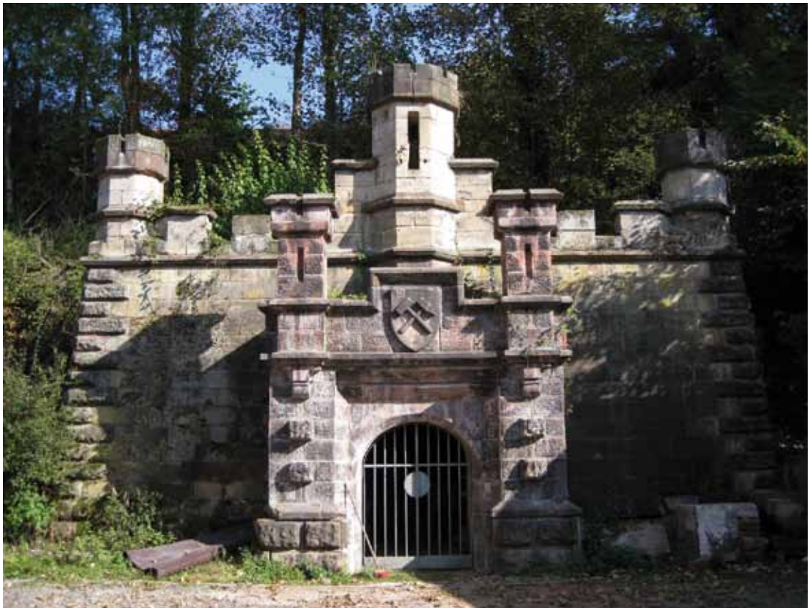
Saarbrücken-Von der Heydt: Mundloch-Eingangsarchitektur zum „Bierkeller“ (1875).
