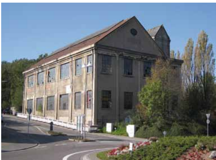
Sulzbach-Hühnerfeld: Umspannwerk (um 1925).
