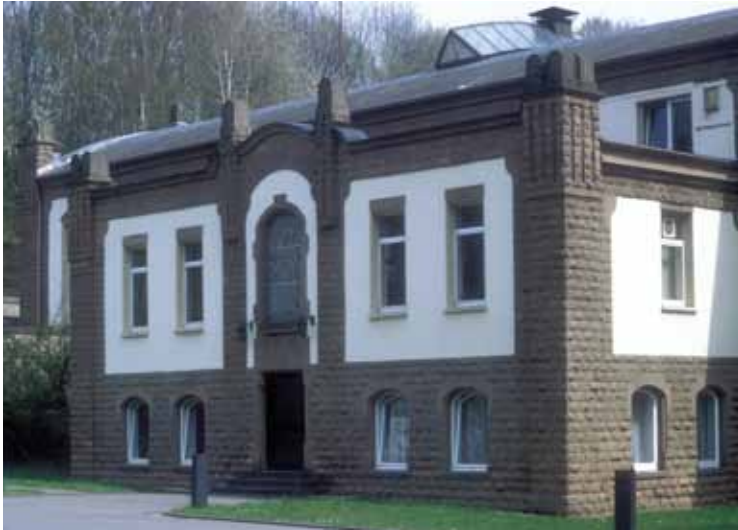
Friedrichsthal: Ostschachanlage, vormals Haupttrittsstelle – Zechenhaus (1907).
