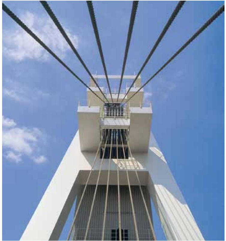
Lebach-Falscheid: Fördergerüst des Nordschachts des Bergwerks Saar (1986/87).
