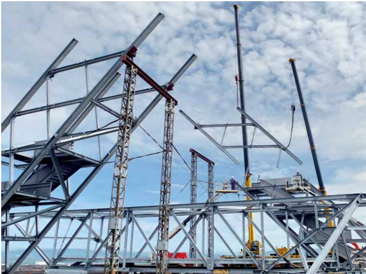
Einheben einer Fachwerksscheibe Vormontage der Brücke
