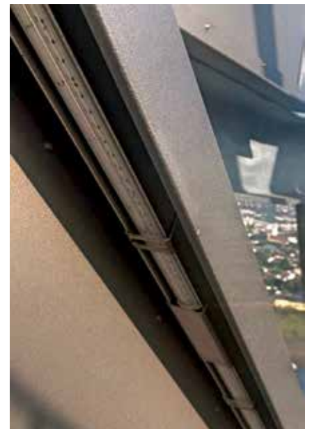
LED Lichtbänder in den Umkantungungen
