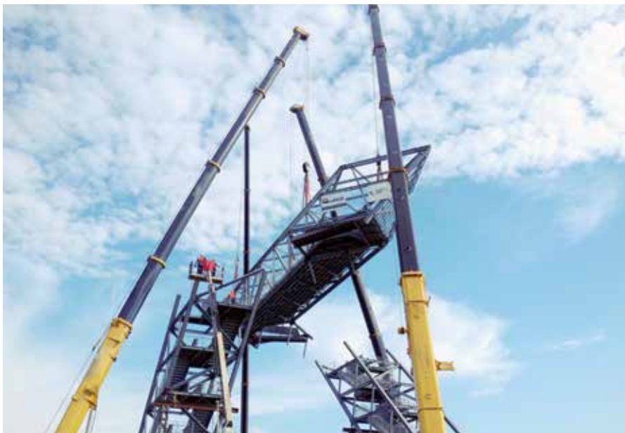
Brückenhub mit 4 Mobilkränen
