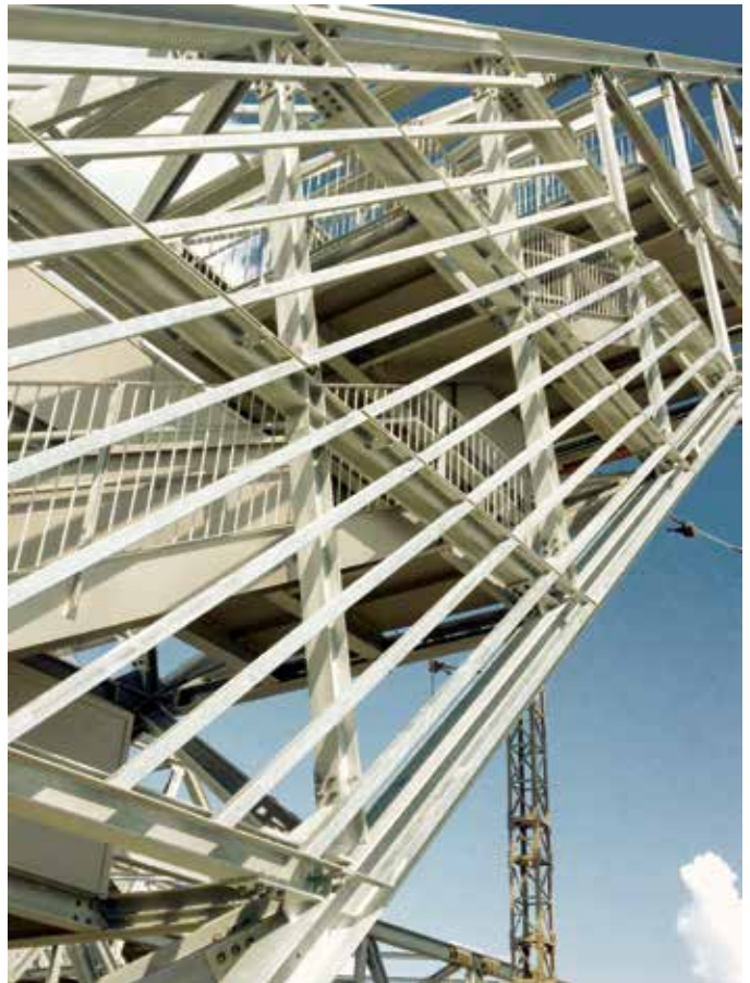
Fassadenelement Quadrathohlprofile
