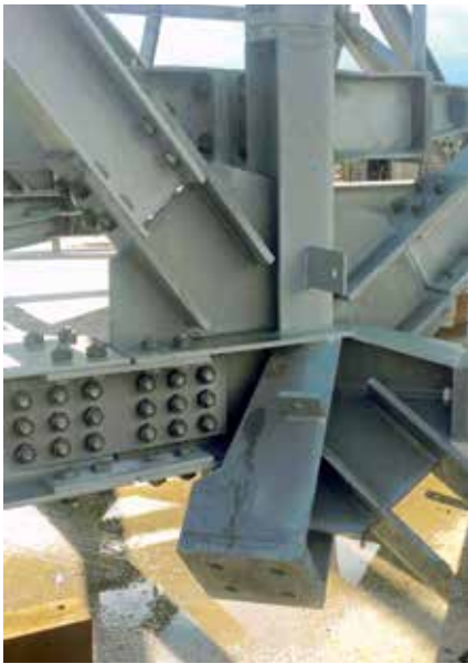
Eckknoten Brücke / Schrägturm
