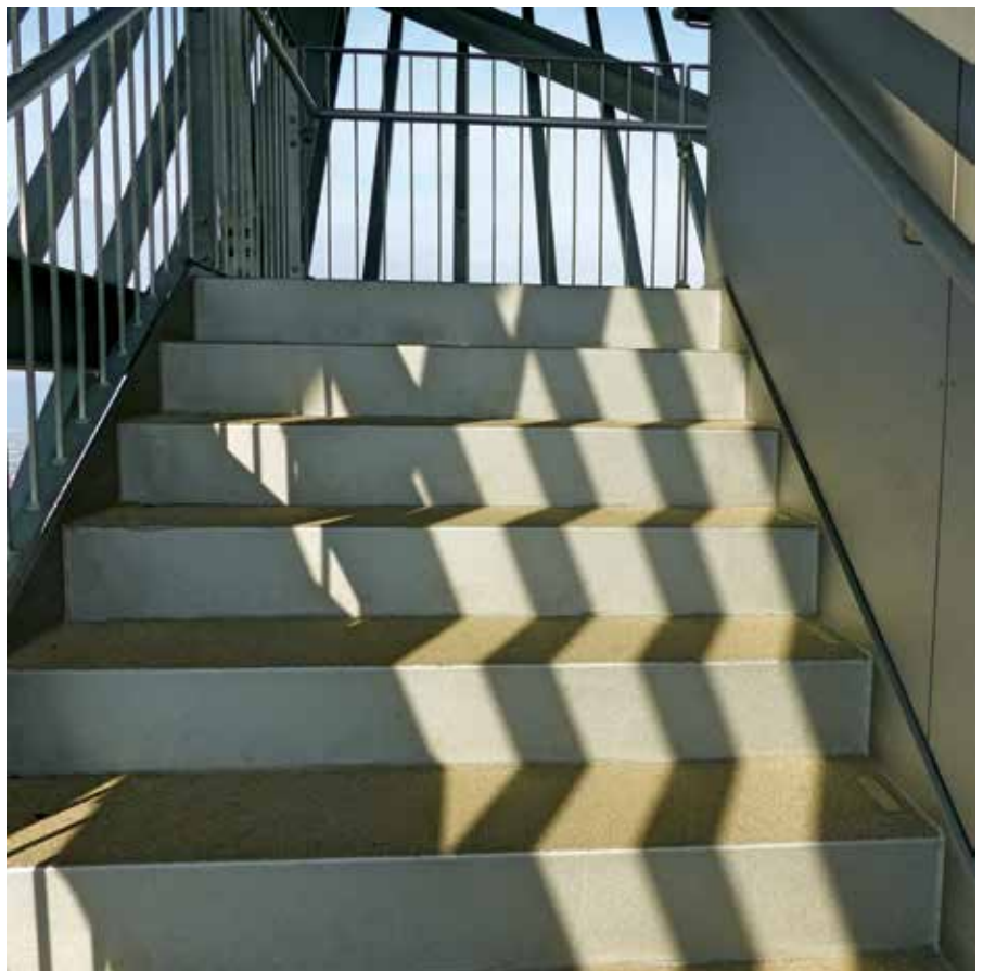
Treppenanlage aus 3 mm Falblech, mit RHD-Kunststoffbelag
