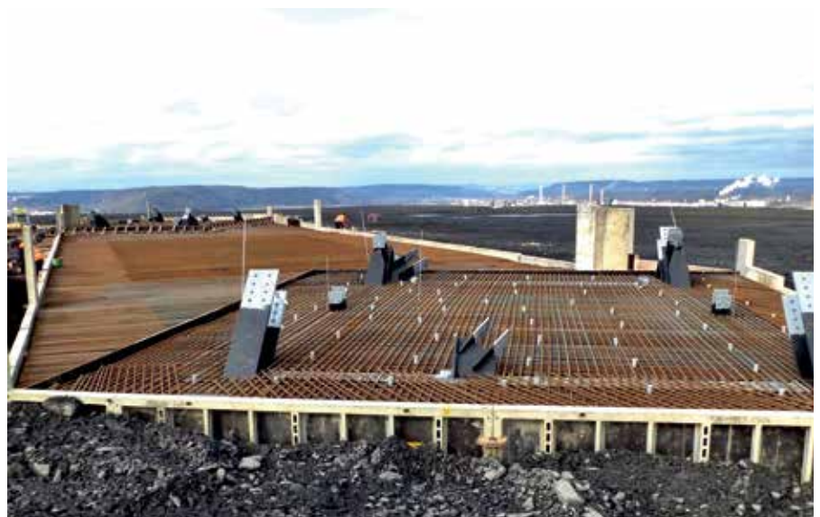
Flächenfundament mit Stahlrahmen und Verbindungszerplatte
